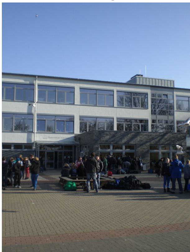
Die Haustechnik der Realschule wird komplett modernisiert
